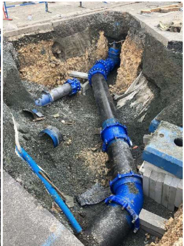
Renouvellement de 1km DN700 Marais de Coulonge / Raccordement DN 400 Bd Joffre La Rochelle
