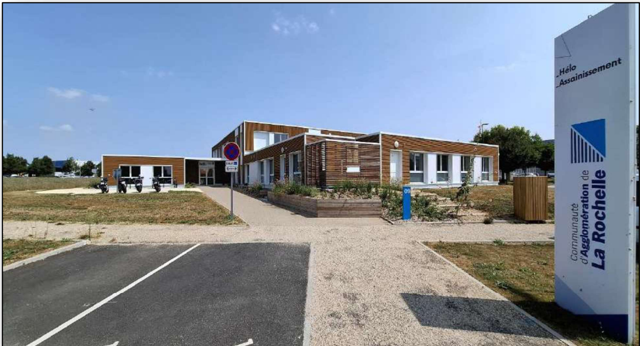
Pole accueil de la régie hélo – 9 rue Anita Conti à Périgny
