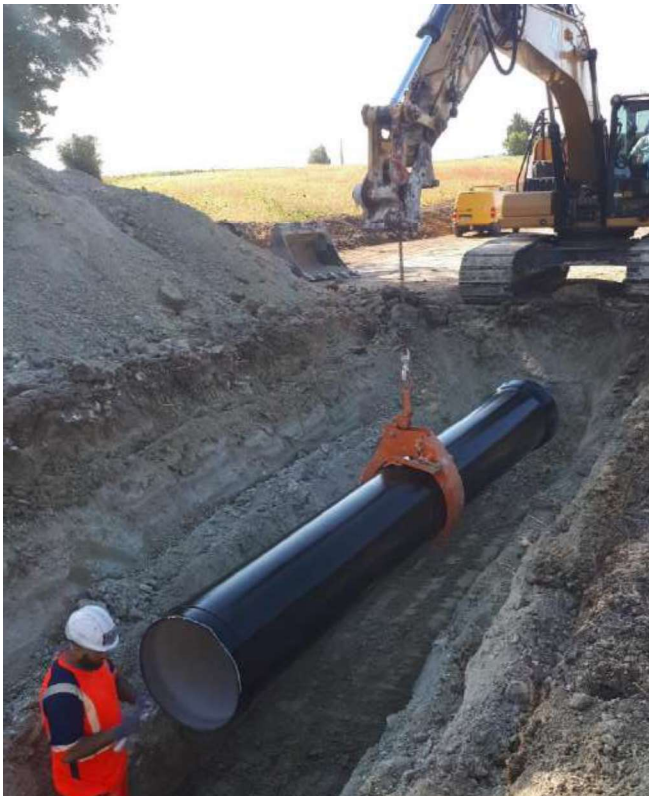
Renouvellement de 1km DN700 Marais de Coulonge / Raccordement DN 400 Bd Joffre La Rochelle
