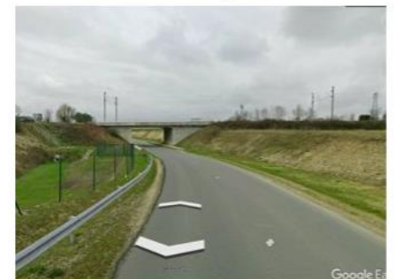
Arrivée sur l'ouvrage d'art
